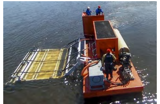
Barge pour l'installation de la toile de jute
